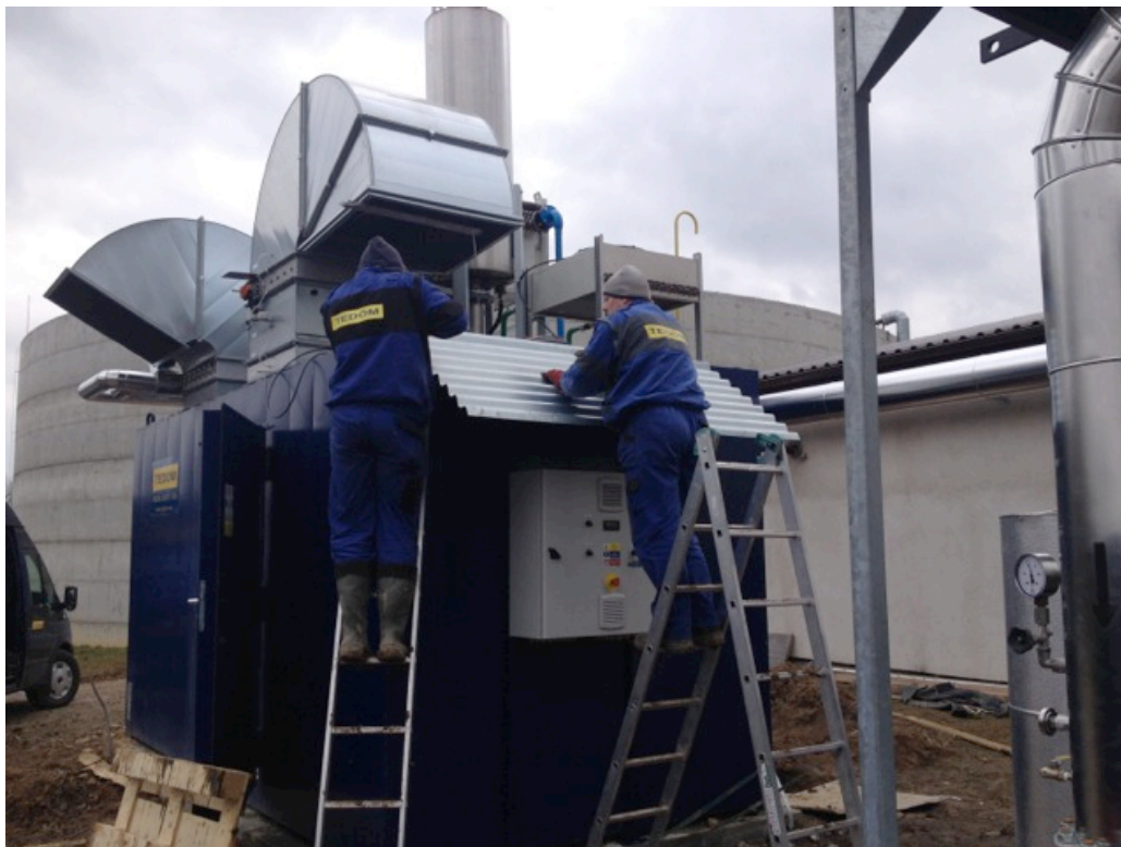
Kompletace kogenerační jednotky
