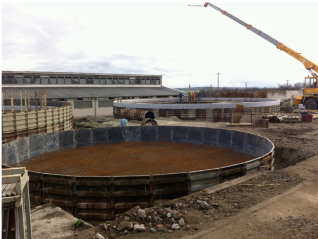
Příprava vstupní jímky
