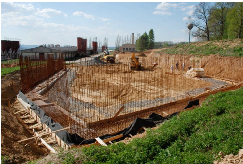
Výstavby silážního žlabu
