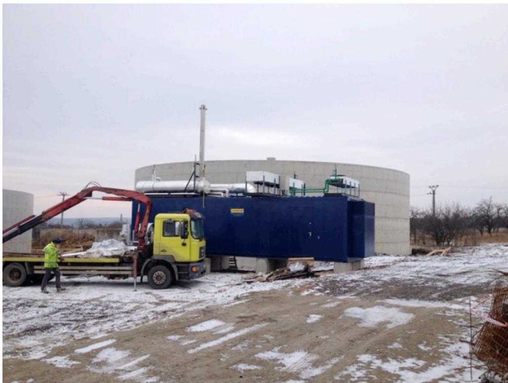
Kompletace kogenerační jednotky
