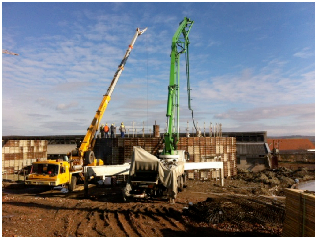
Betonáž jednoho z fermentorů
