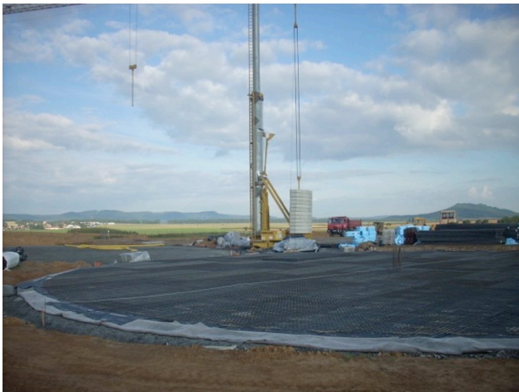
Výstavba základové desky jednoho z fermentorů
