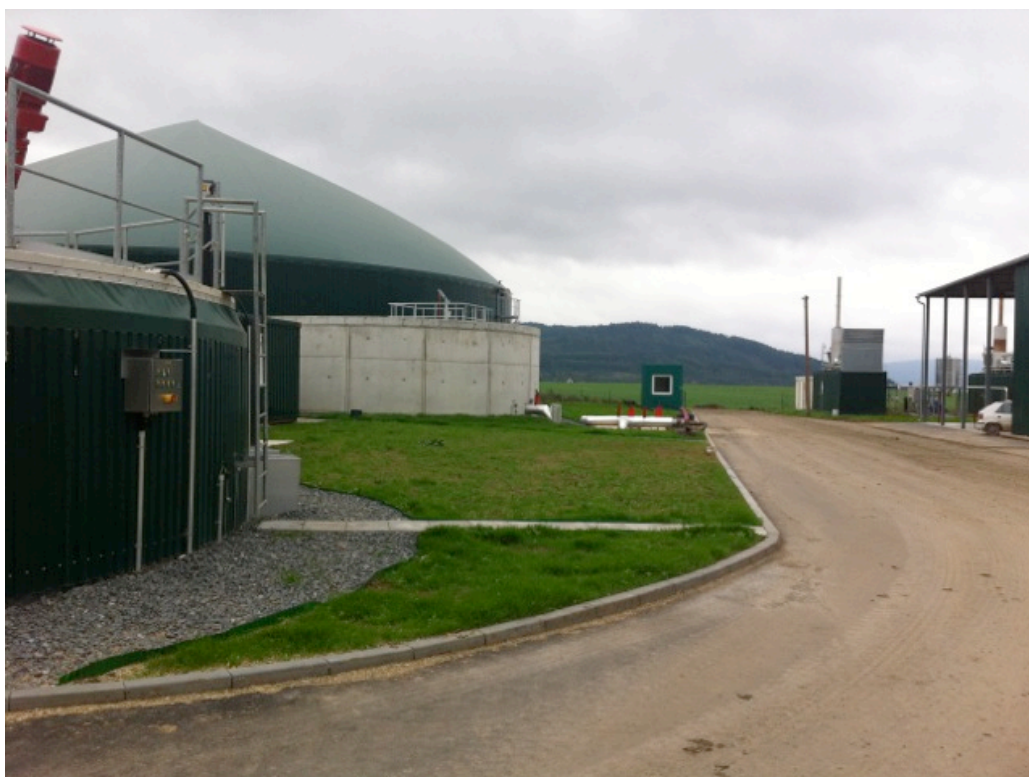
Bioplynová stanice Děřichov po dokončení
