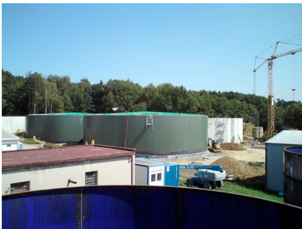
Bioplynová stanice Sázava před dokončením
